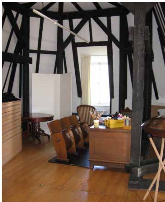
Raum im Dachgeschoss der Villa Erckens, der zukünftig umgebaut und hergerichtet werden soll
