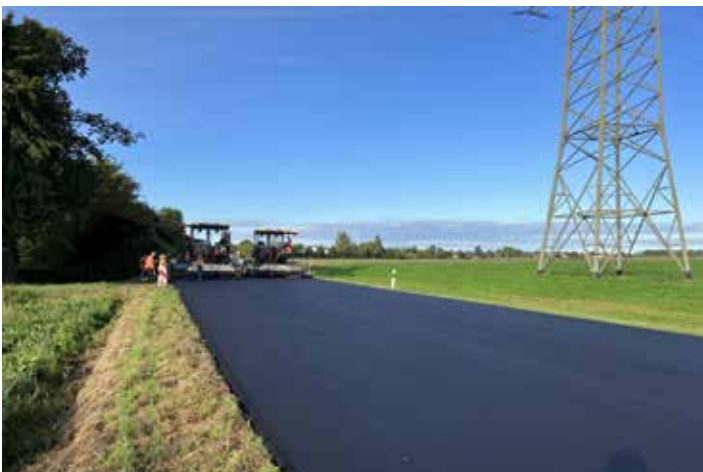
Blick auf die K 33 vor dem Anbringen der Fahrbahnmarkierungen: Die Kreisstraße erhielt Ende 2023 zwischen Grevenbroich-Neukirchen und Neuss-Rosellerheide eine neue Fahrbahndecke mit langlebigem Asphalt.
