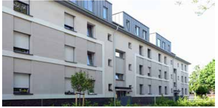
Ebenfalls bereits saniert: Am Alten Hof 3-9
