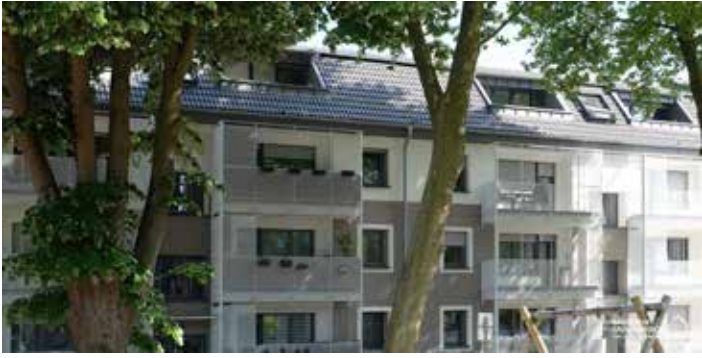
U.a. hier wurden die Sanierungsmaßnahmen bereits abgeschlossen: Am Alten Hof 2-8.
